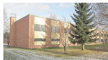
Kiuruvesi KT 2 h, k 53 m 2 2. krs. Erätie. Rak. -75. Ylimmän kerroksen siistikuntoinen vapaa koti luhtitalossa. Keittiö juuri remontoitu. Vuokrattu. Mh. 45.000 € 7025560
