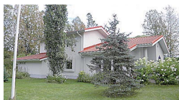
Lapinlahti OKT n. 165/233 m 2 Linnanniementie. Rak. -88. Yk: Aula, mh, w/ph. Ak: Mh, tkh, k+rt, oh, 2 wc, khh, vh, saunatilat. Varastot, autotalli. Oma tontti 0,1563 ha. Tässä uniikki kiviotalo, jossa avaruutta ja tilaa. Keittiö/ruokailutila suoraan kutsuu kokkailemaan ja ruokailemaan perheen tai ystävien kesken. Ja tunnelmoida joka alakerran tai yläkerran takan ääressä nauttien hämärästä illoista. Mh. 249.000 € 7056049
